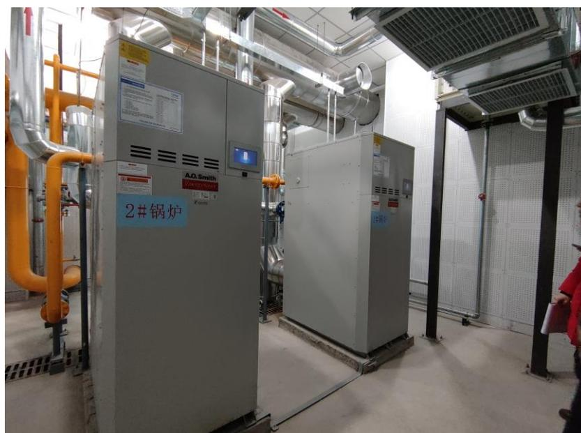
图 8 锅炉低氮燃烧器
