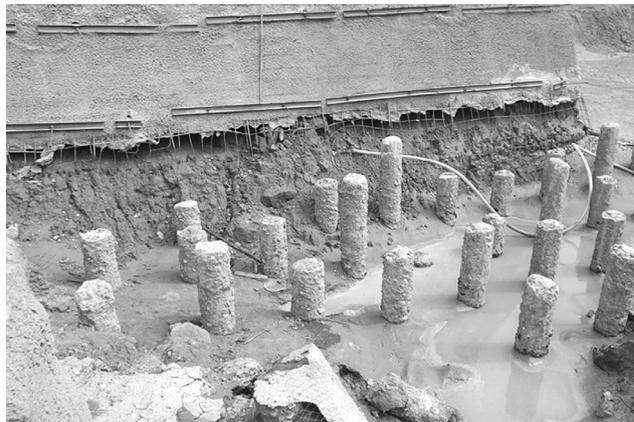
图8 坡脚被基坑内雨水浸泡造成的土钉墙破坏
