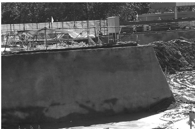
图5 基坑侧壁为黏性土的土钉墙破坏
