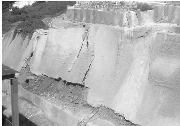
图6 基坑侧壁局部粉土部位土钉墙破坏
