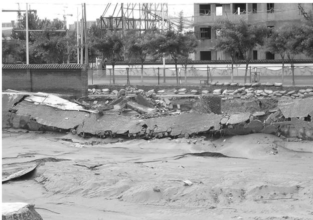
图3 基坑侧壁为填土的土钉墙破坏
