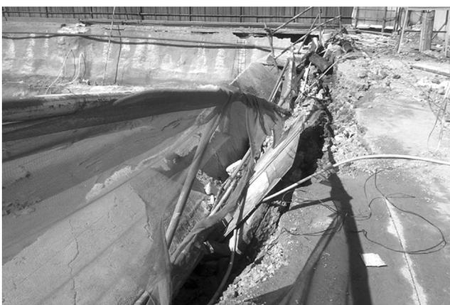
图9 雨水由坡顶进入面层内造成的土钉墙破坏
