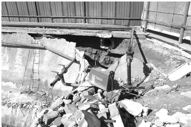
图7 基坑侧壁原管道进水造成的土钉墙破坏
