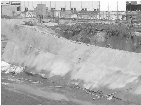
图4 基坑侧壁为粉土和砂土的土钉墙破坏
