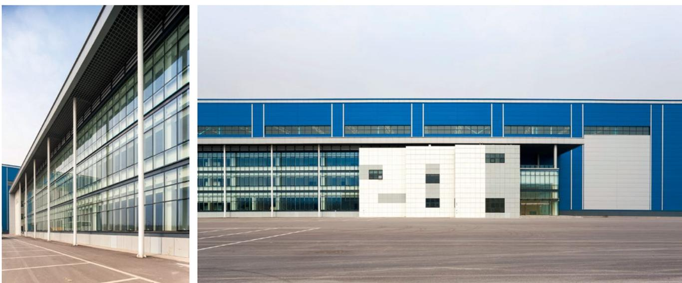
项目建筑主体外立面采用横向蓝色夹芯钢板外饰，生产附楼、电气试验附楼采用灰蓝色玻璃幕墙、白色铝板及浅灰色外墙涂料，建筑形象舒展大气、简洁内敛。
